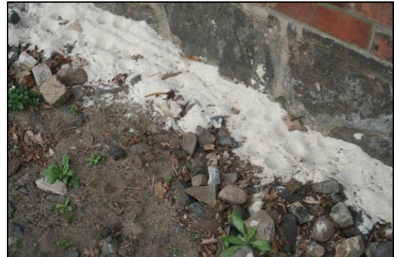
Abb. 3: Die Trichter befinden sich auch im humushaltigen feinen Sand und zwischen den Steinen. Insgesamt konnten am Haus, bevorzugt an der Ostseite, 120 Trichter am 1.5.12 gezählt werden.
