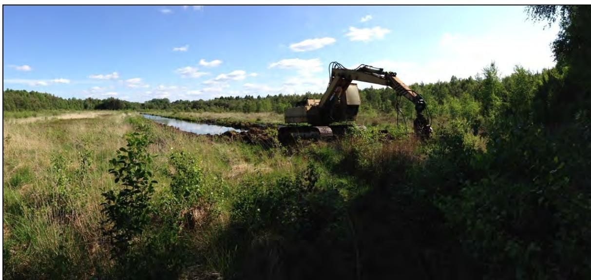
Bild 6 – Bereich 4a, Abbau von Torf auf der südlichen Fräsfläche mit einem Bagger
