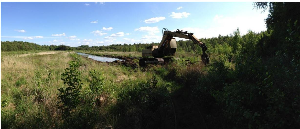
Bild 6 – Bereich 4a, Abbau von Torf auf der südlichen Fräsfläche mit einem Bagger
